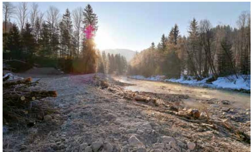
*Nach Unwetter vom 29. Juli 2019 sanierter Uferschutz und gleichzeitige Aufweitung der Lammer im Bereich "Lammerer"*
